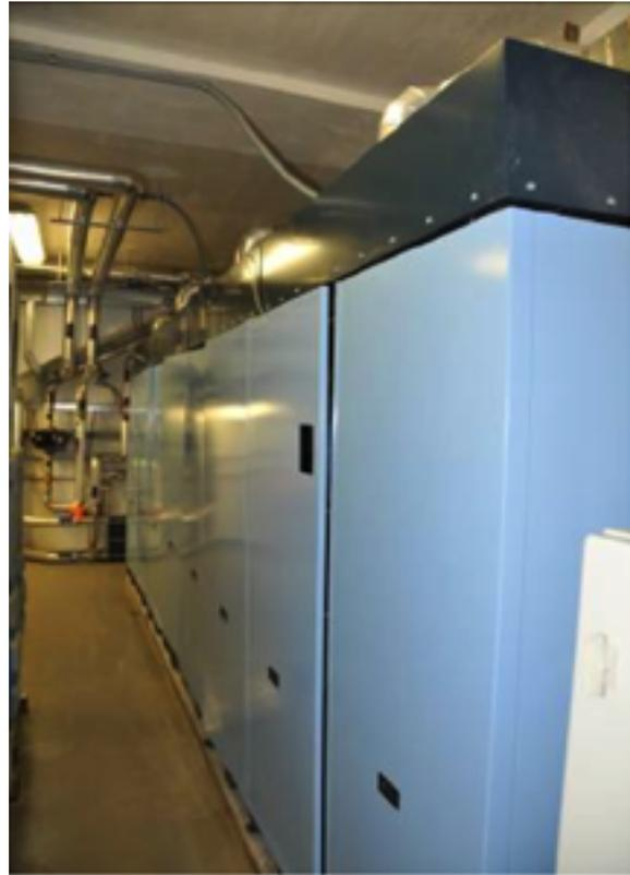
Figura.30. Máquinas de absorción Fuente CIEMAT-ARFRISOL
