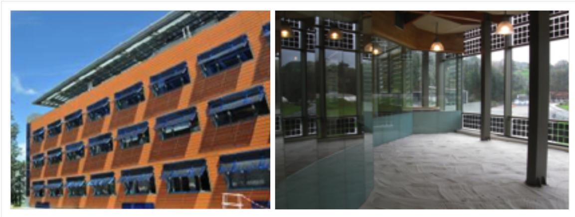
Figura.27. Dos edificios con módulos PV semitransparentes en fachada. (fuente CIEMAT-ARFRISOL)
